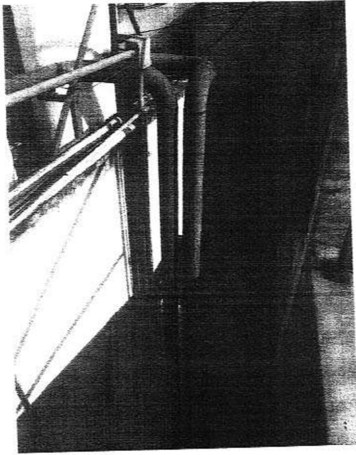
Foto 5 – Vista parcial de los caños en tramo vertical. Las nuevas cañerías en terraza se conectarán a la altura de las soldaduras luego de la curva a 90°.
